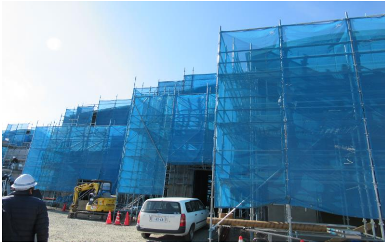
【外観】 BOX を雁行した配置
